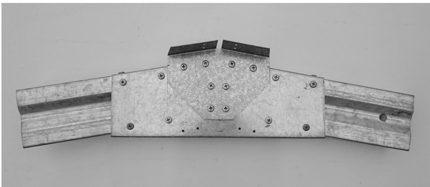
RIDGE PLATEとAPEX PLATEの接合
