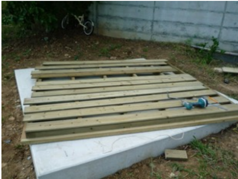
根太の構築が完了しました
